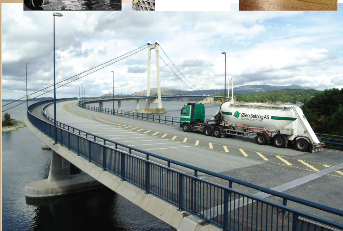
Foto: P. Bugge/Ølen Betong
