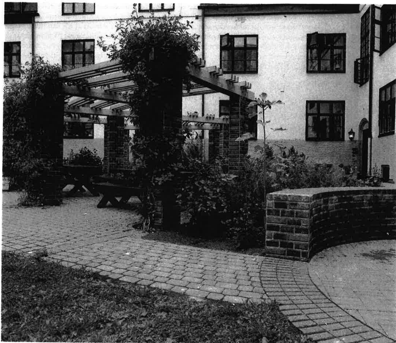
På midten av 80-tallet ble det satset på bedre bomiljø i mange bygårder. Bakgården i Sarpsborggt. 16, en gammel murbygning i Oslo, ble rehabilitert bl.a. med midler fra Norges Betongindustriforbund og produkter fra tre produsenter av belegningsstein. Betongstein er brukt som forblending av murer og søyler, og passen er belagt med heller og belegningsstein.
