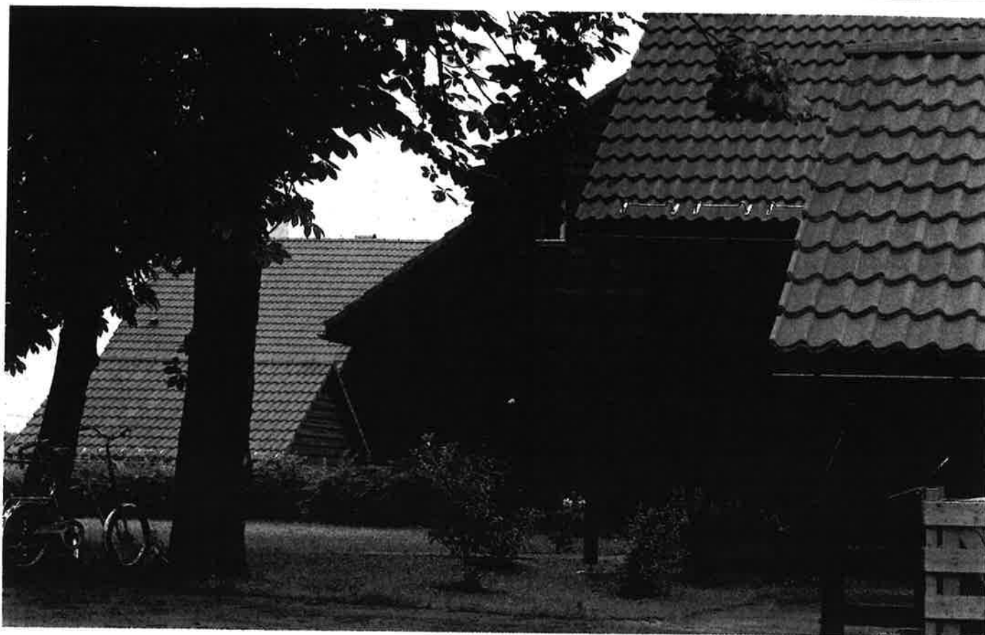
Betongtakstein er med på å gi huset et dekorativt utseende.
