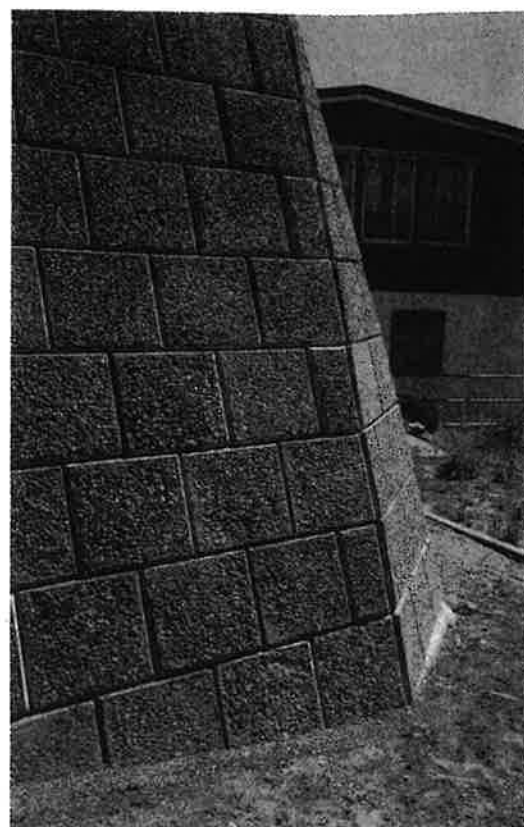
Forstøtningsmur av betongblokker
