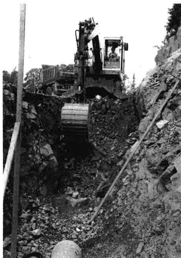
Fra forsøksprosjektet med bruk av stedlige masser ved omfylling av betongrør.
