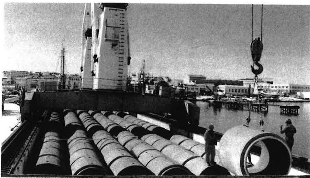
Lossing av norske betongrør til Reykjavik kommune i forbindelse med rehabilitering av avløpssystemet i byen. Arbeidet ville pågå i to år. Første del av leveransen på i alt 2500 m rør skjedde i 1990.
