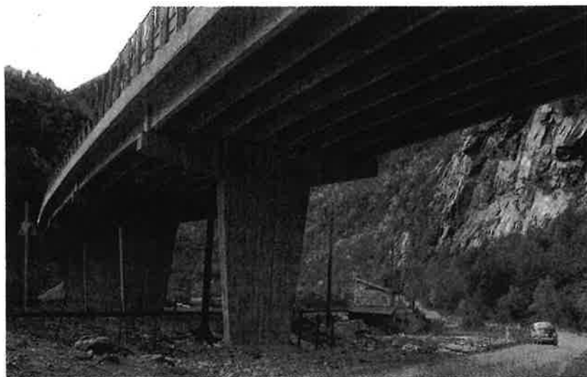
Dalegårdens bro, Hordaland, bygd av forspente NIB-bjelker
