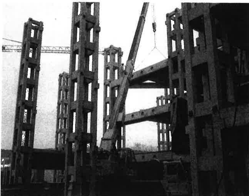
Betongelementer ble tatt i bruk for fullt på byggeplassene.
